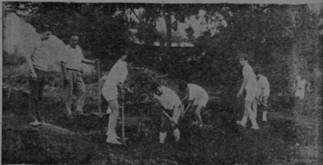
CONSTRUYEN PARQUE. — Varios jóvenes voluntarios laboran en la construcción del Parque Infantil de San Joaquín de Flores, Heredia. Observan un funcionario del Ministerio de Cultura, Juventud y Deportes, a la izquierda y el Prof. Antonio Murillo, directores del trabajo.
